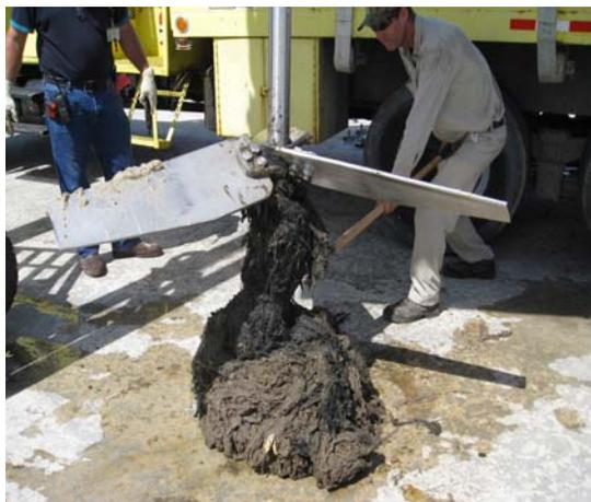
**Figure 2:** *Clearing the impeller*
