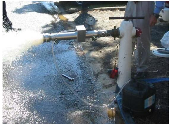
**Figure 8:** *High Conc<sup>n</sup> Dechlorinator*
